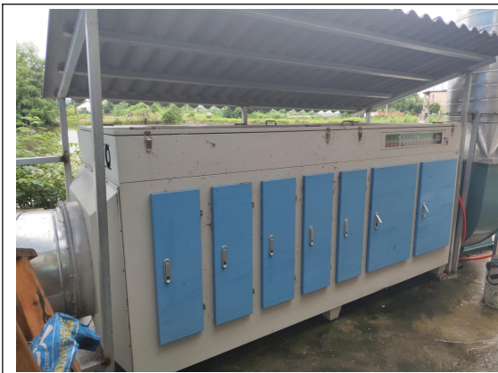
UV 光解设备+15 米高排气筒
