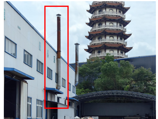
有机废气排气筒
