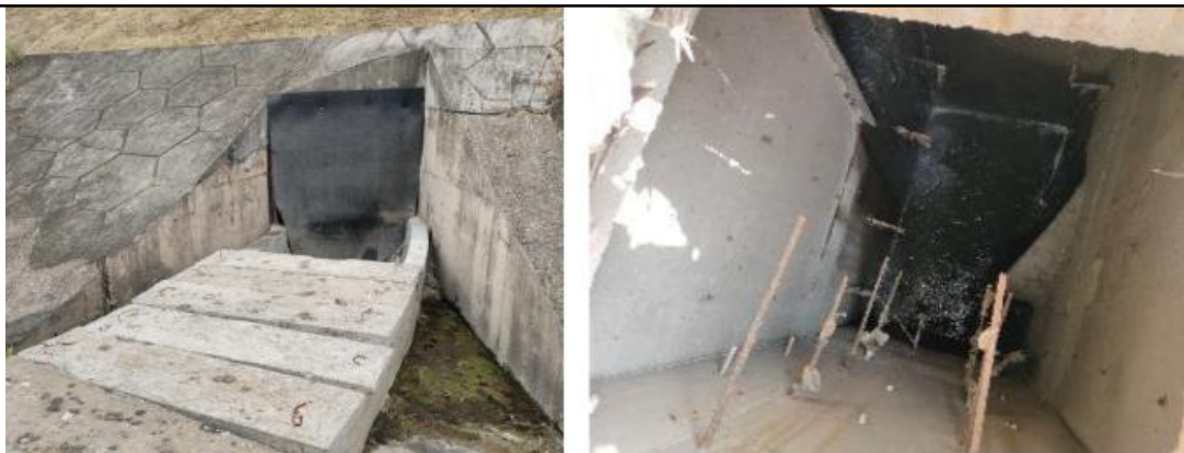
图2-2 友谊河西岸截流井溢流排口现场照片
